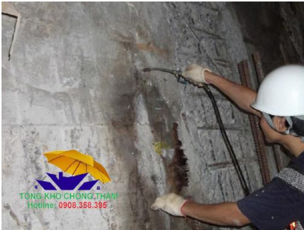
Xử lí nứt bằng cần bơm keo máy Pu
