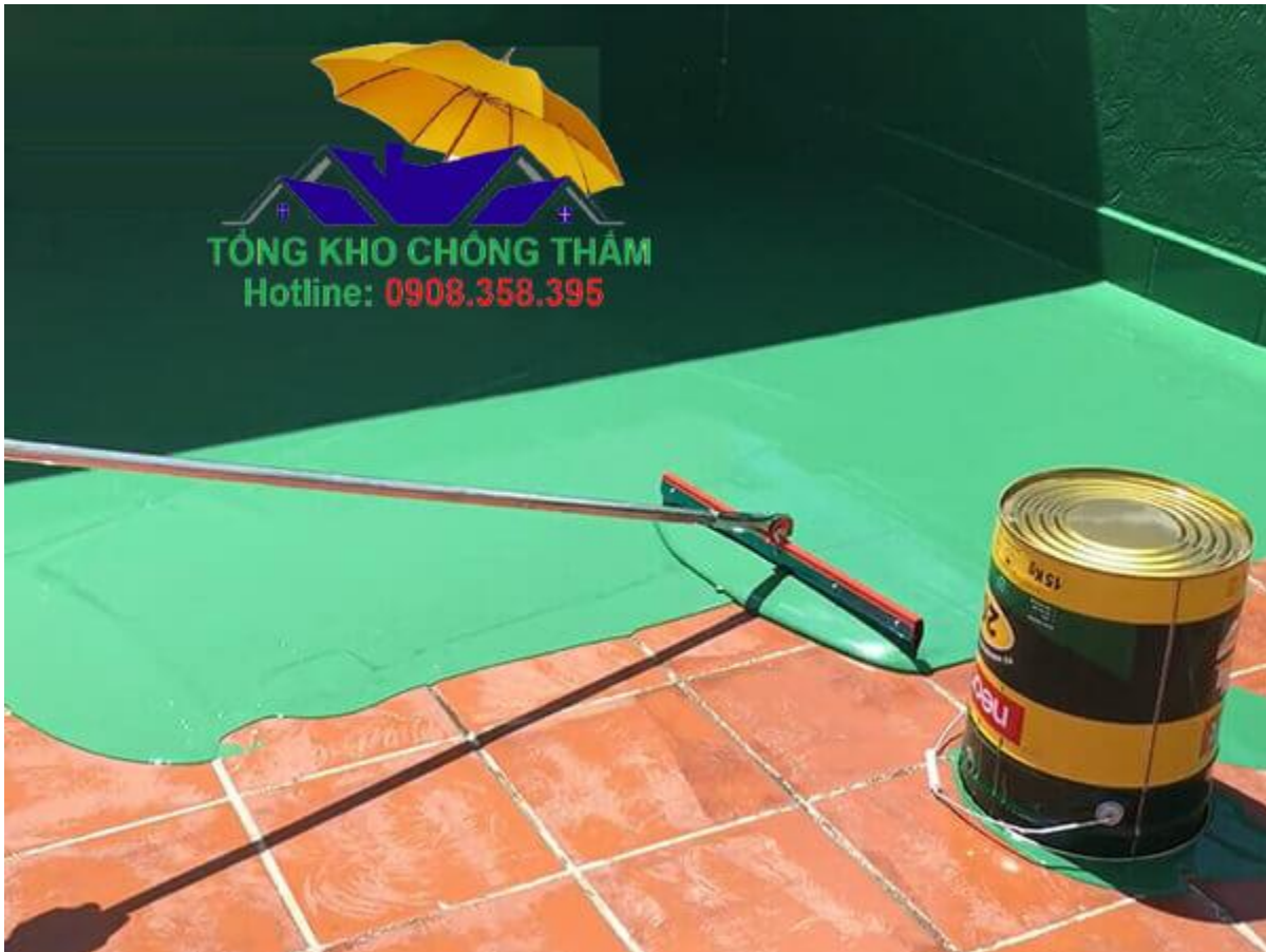
Thi công bàn cào răng cưa
