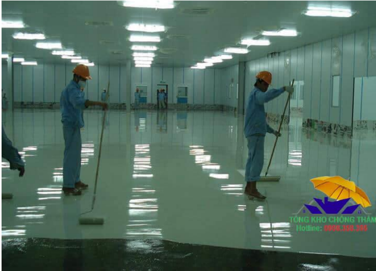
Các bước thi công sơn Epoxy bằng con lăn gai phá bọt khí
