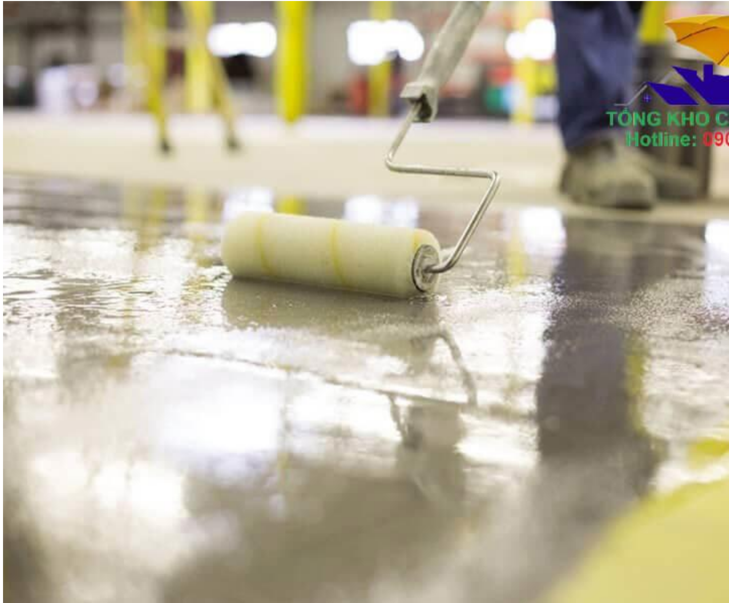
Sử dụng con lăn gai nhựa phá bọt khí
