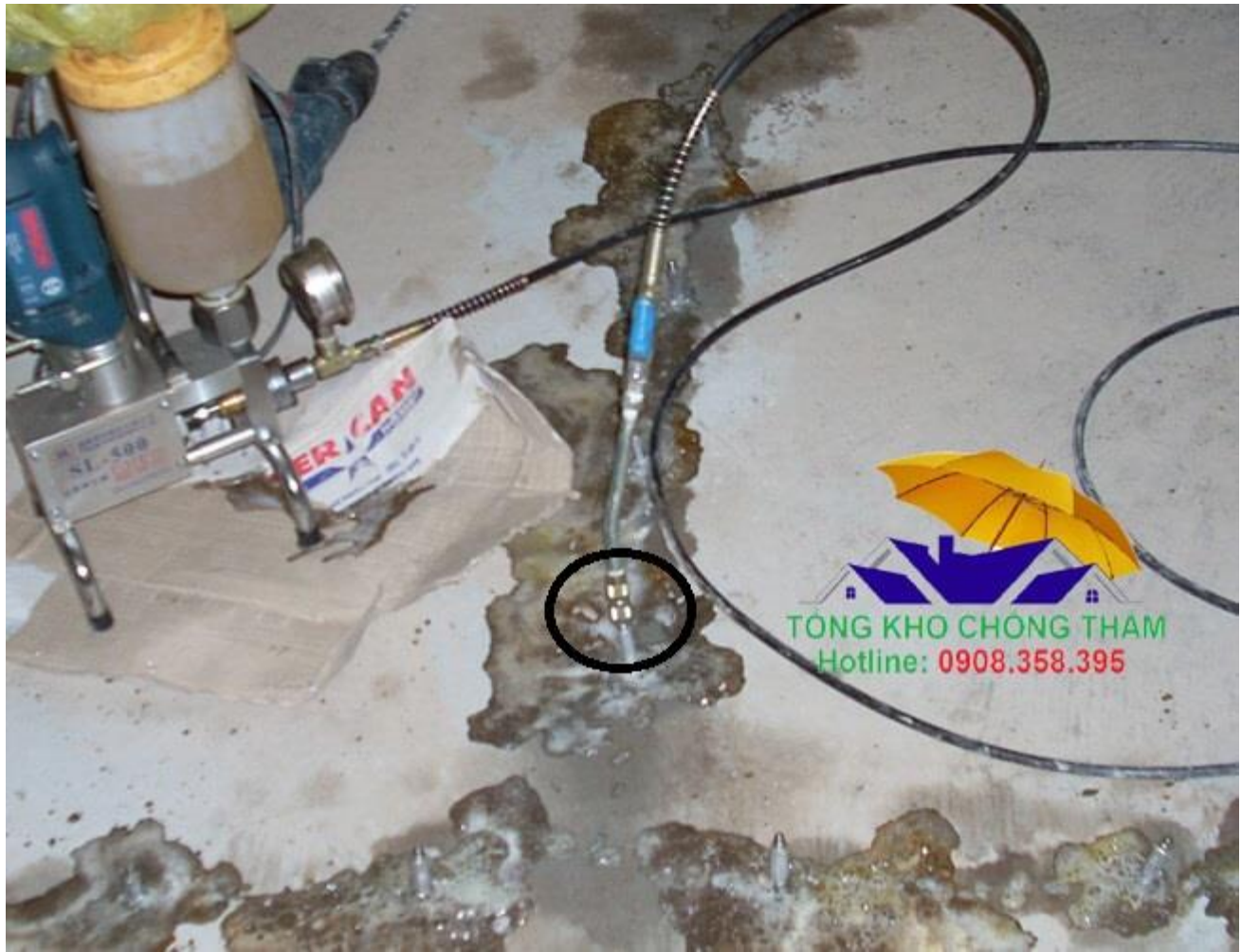
Hướng dẫn cách sử dụng máy bơm keo bằng đầu bơm keo Pu – Epoxy
