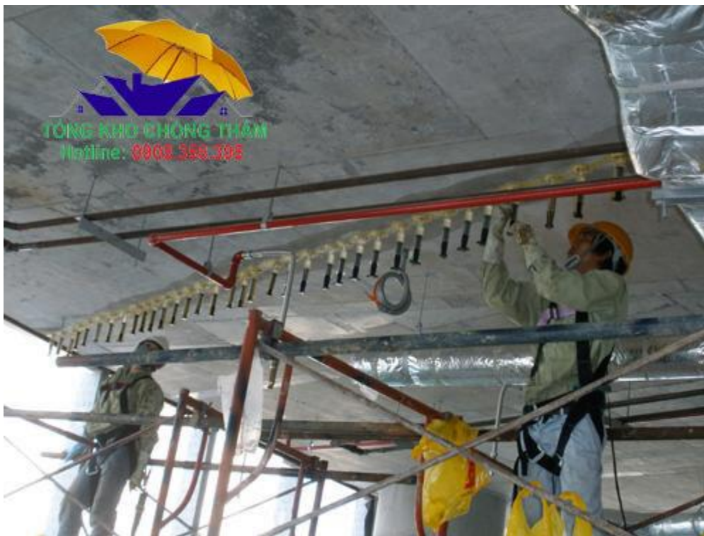
Xử lý nứt bằng keo Epoxy Maxseal 1400
