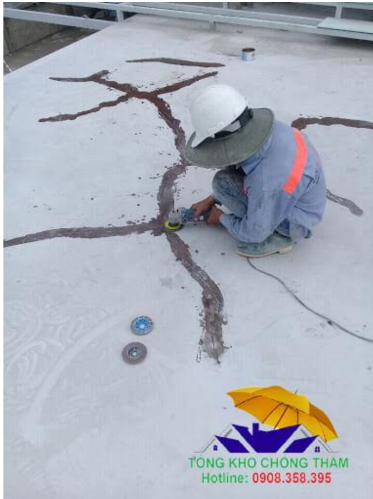
Thi công xử lý vết nứt bằng cách trét keo Epoxy
