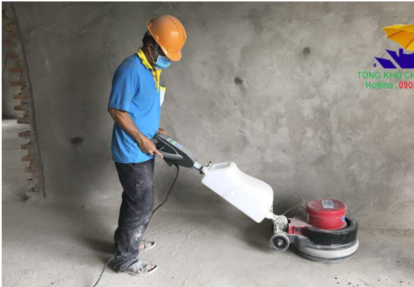
Sử dụng máy mài bê tông
