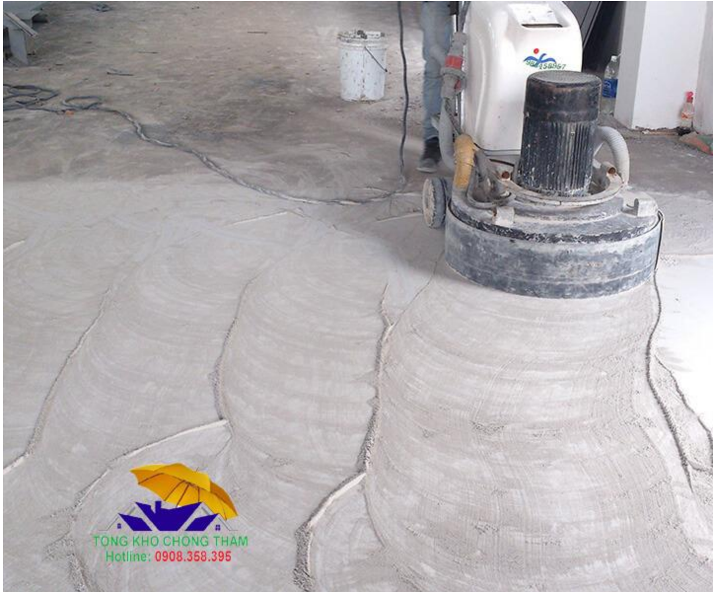
Sử dụng máy mài bê tông bằng lưỡi mài 125mm
