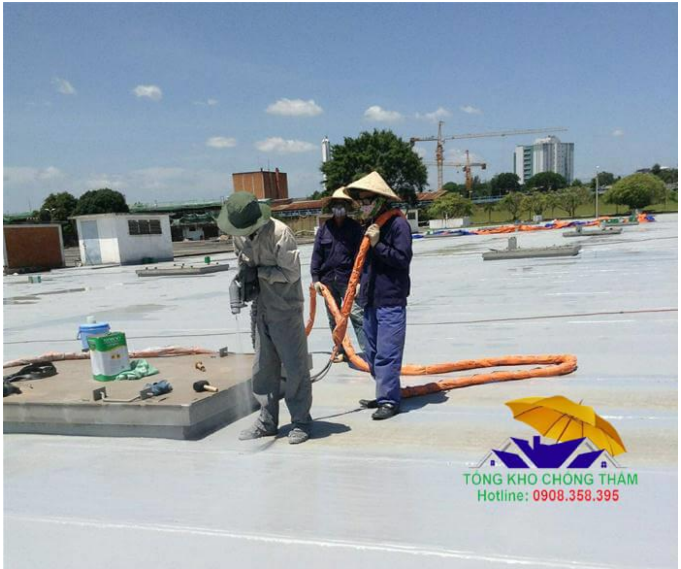
Hình ảnh minh họa cách phun chống thấm bằng máy
