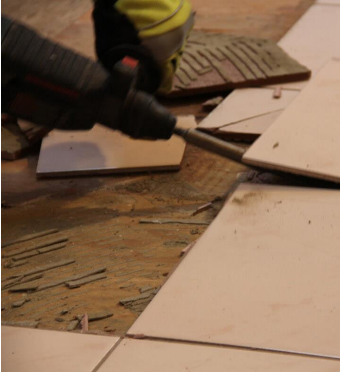
Mũi đục bê tông dẹp ứng dụng trong cách gỡ gạch lát nền
