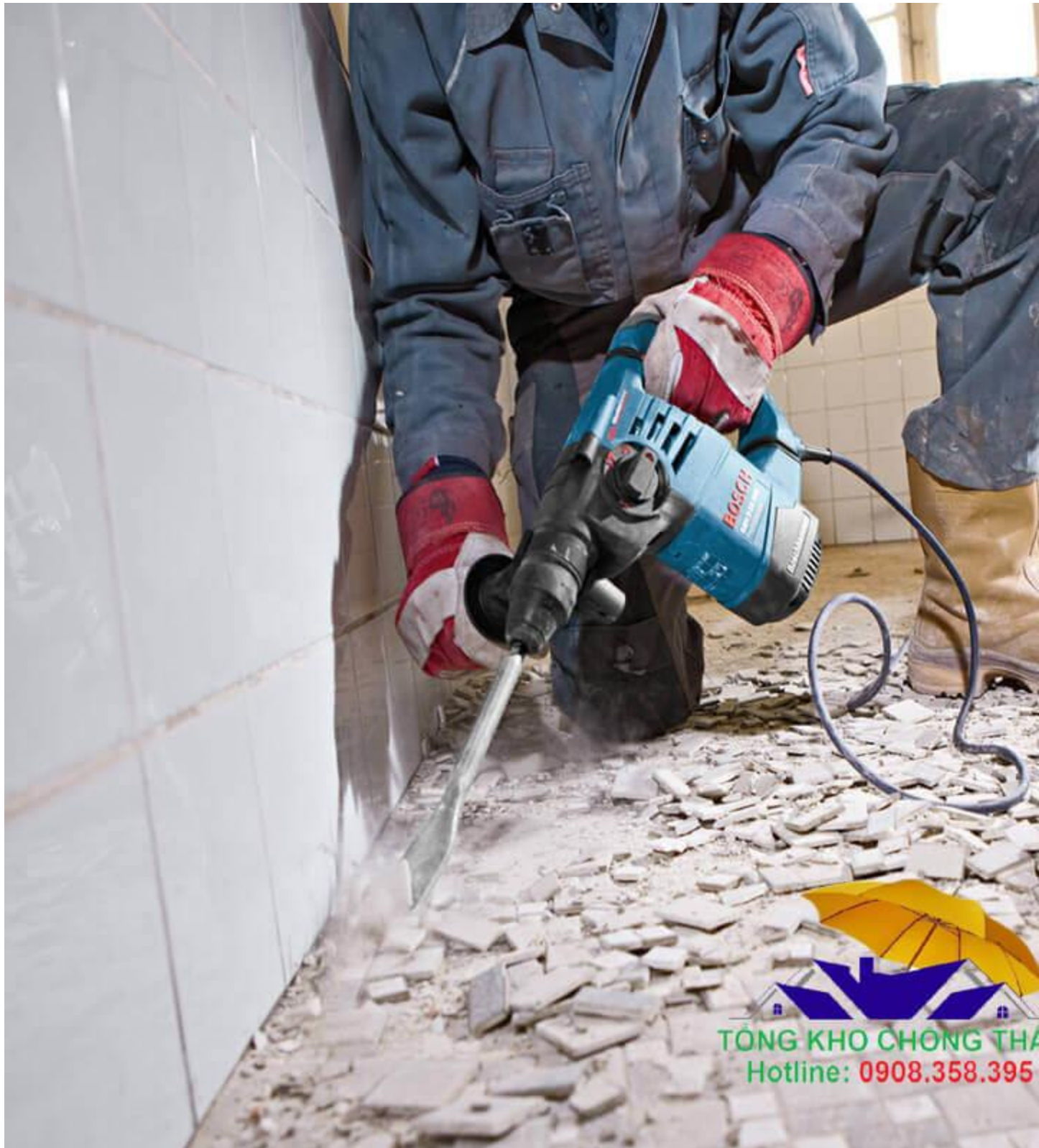
Ứng dụng của mũi đục bê tông dẹp trong việc đục bỏ gạch
