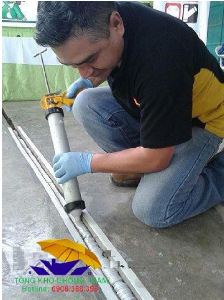
Hướng dẫn thi công bắn keo bằng súng
