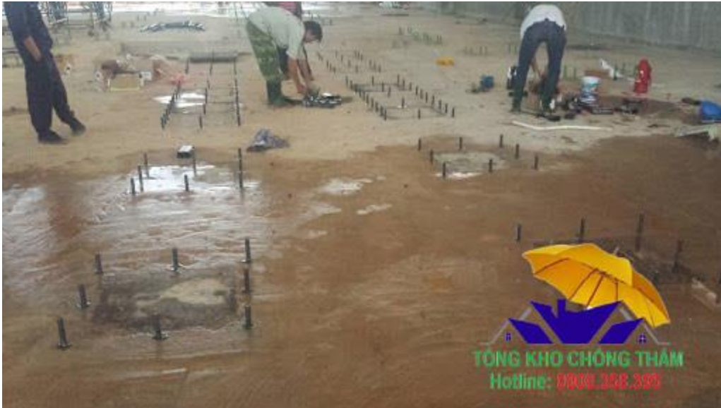
Hướng dẫn thi công hoá chất cây thép Fastfix X7
