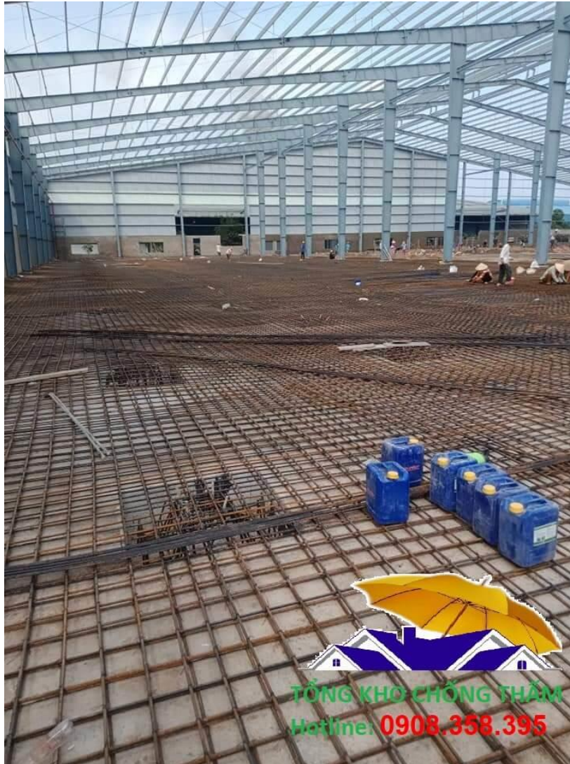
Thi công hóa chất tẩy rỉ Rustcons 117 M tại công trình
