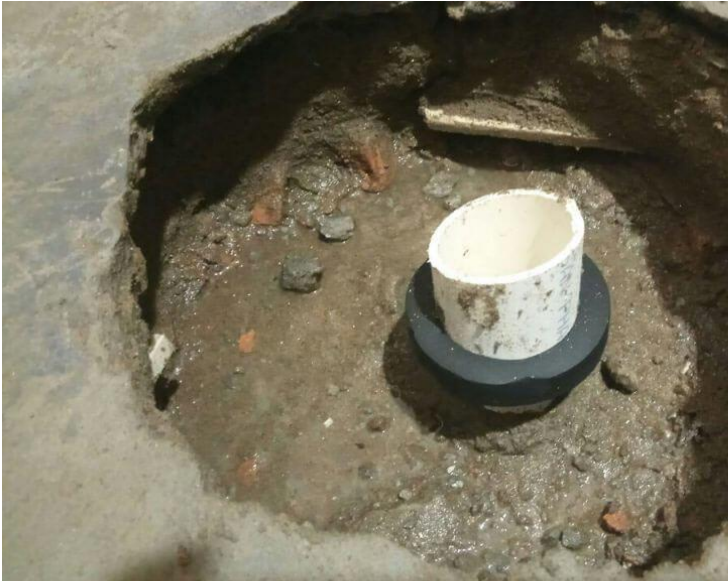
Hướng dẫn cách thi công chống thấm cổ ống bằng thanh trượng nở
