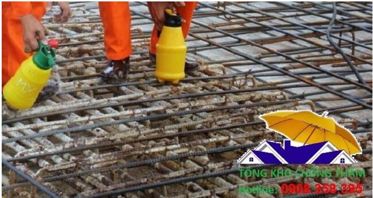
Thi công chất tẩy gỉ sắt thép
