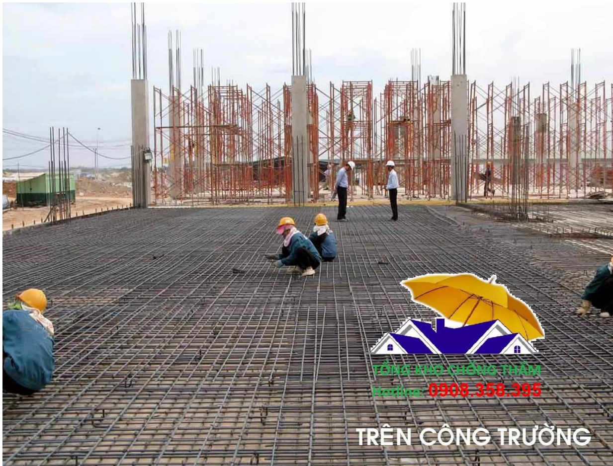
Xử lý rỉ sét tại công trình xây dựng
