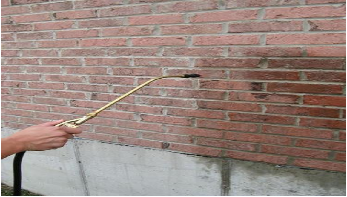
Hình ảnh: Phun chống thấm cho tường gạch không trát
