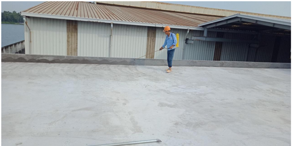
Hình ảnh: Phun chống thấm sàn mái nhà máy
