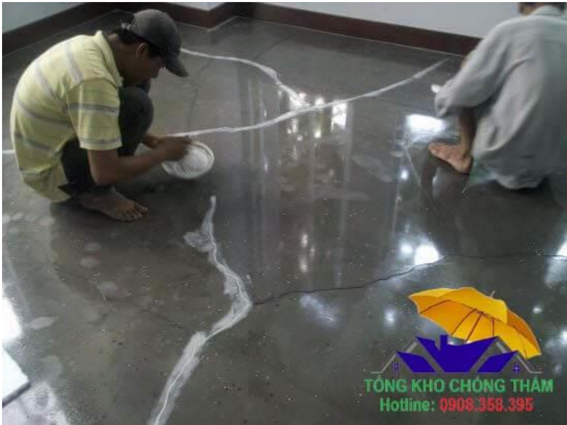
Cách thi công bột bả trám trét gốc Polyurethane
