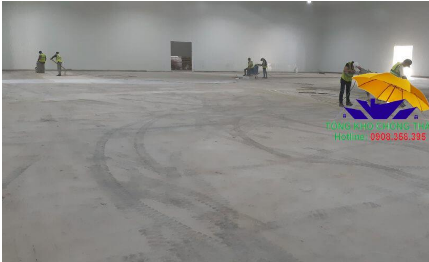
Hình ảnh minh họa khi mài sàn bê tông bằng máy mài có hút bụi
