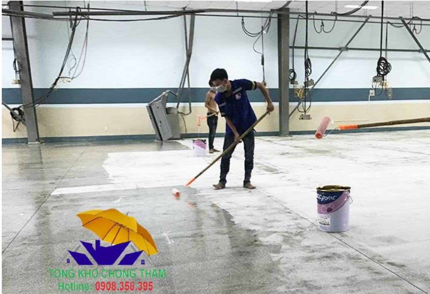
Thi công sơn lót Epoxy KCC Hàn Quốc đúng cách
