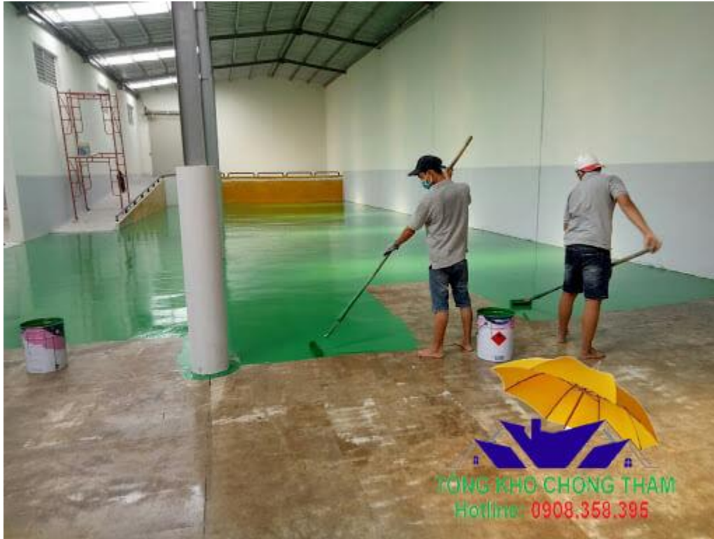
Cách thi công sơn lót Epoxy chuyên nghiệp
