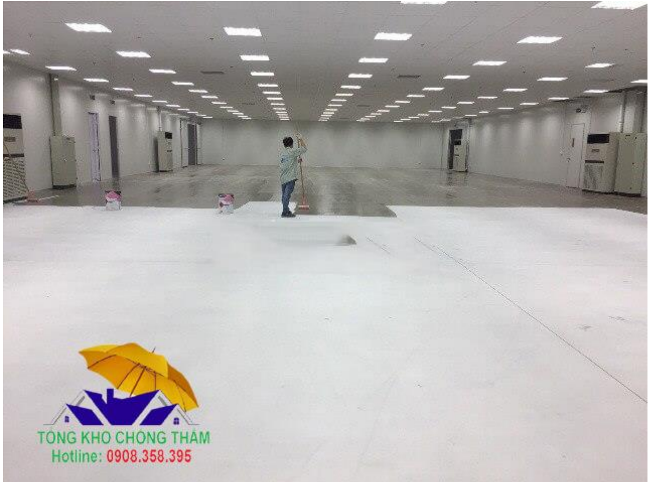
Thi công sơn lót Epoxy tạo kết nối
