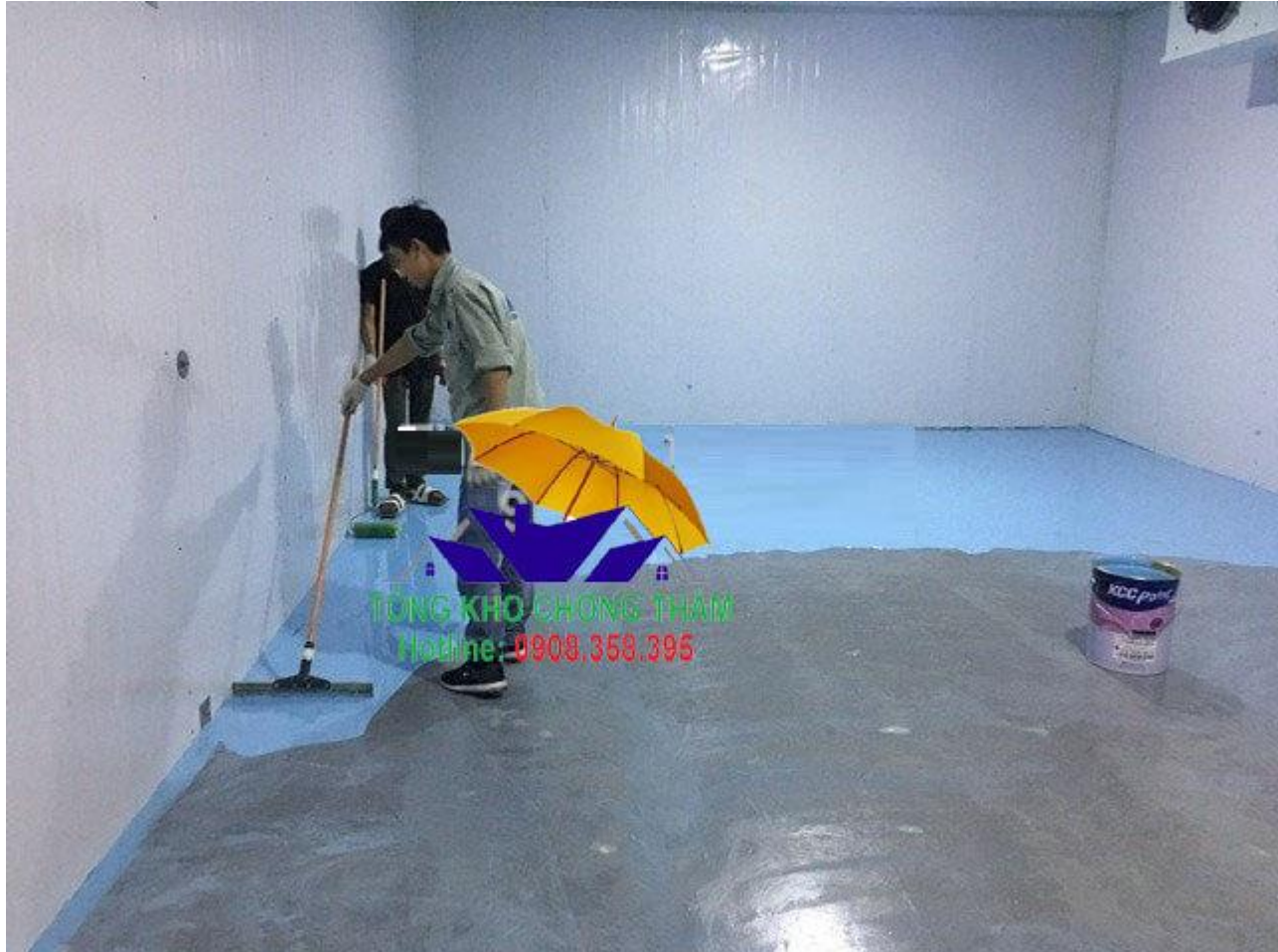
Thi công sơn phủ tự san phẳng Epoxy Unipoxy Lining
