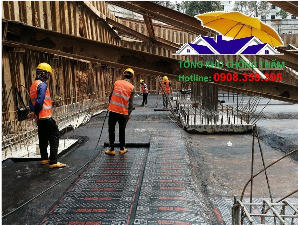
Thi công màng chống thấm tầng hầm
