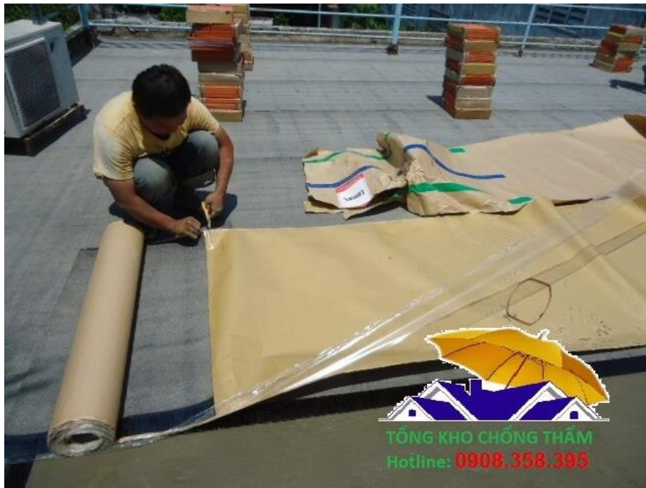
Tiến hành cắt màng phù hợp kích thước cần thi công
