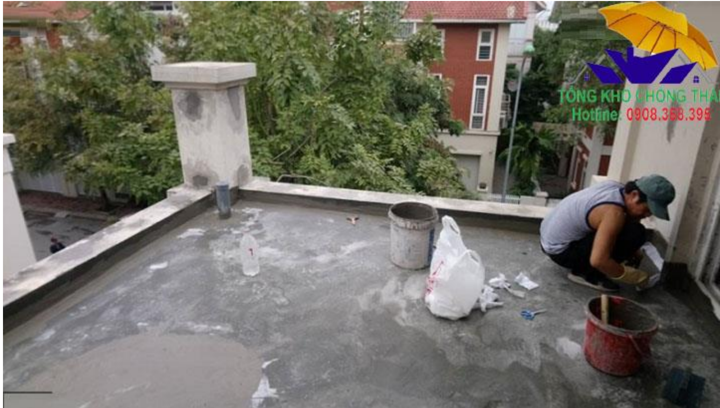
Quy trình thi công chống thấm ngược bằng Maxbond 101
