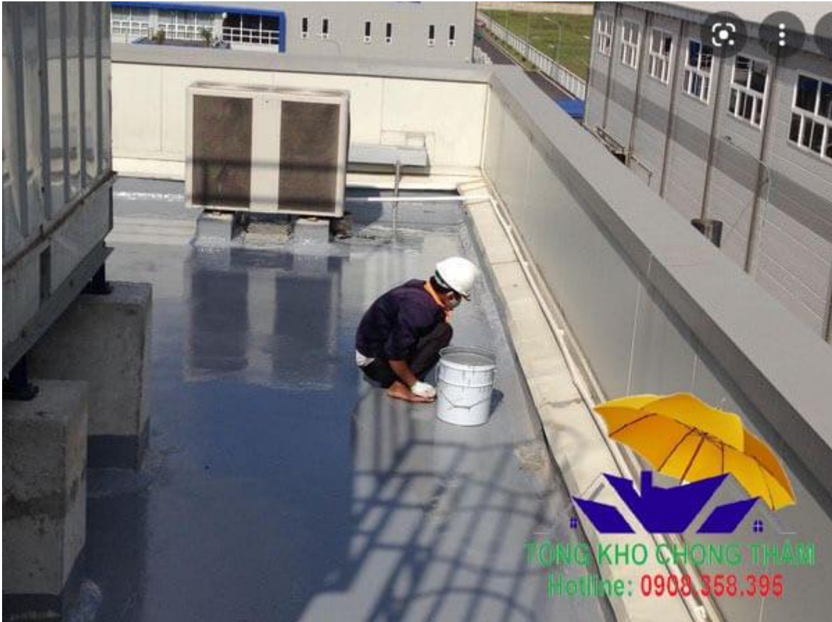
Hướng dẫn cách thi công màng chống thấm Maxbond 328E
