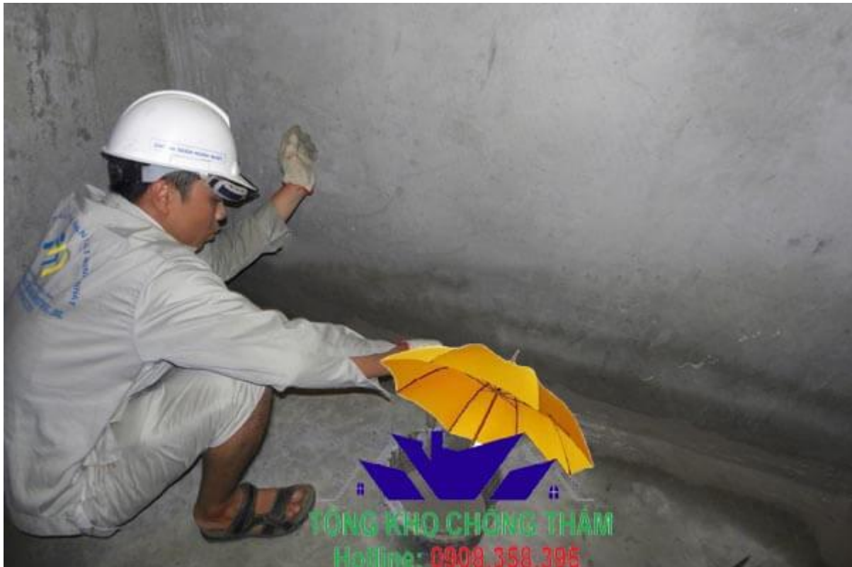
Hướng dẫn thi công chống thấm tạo hồ dầu kết dính
