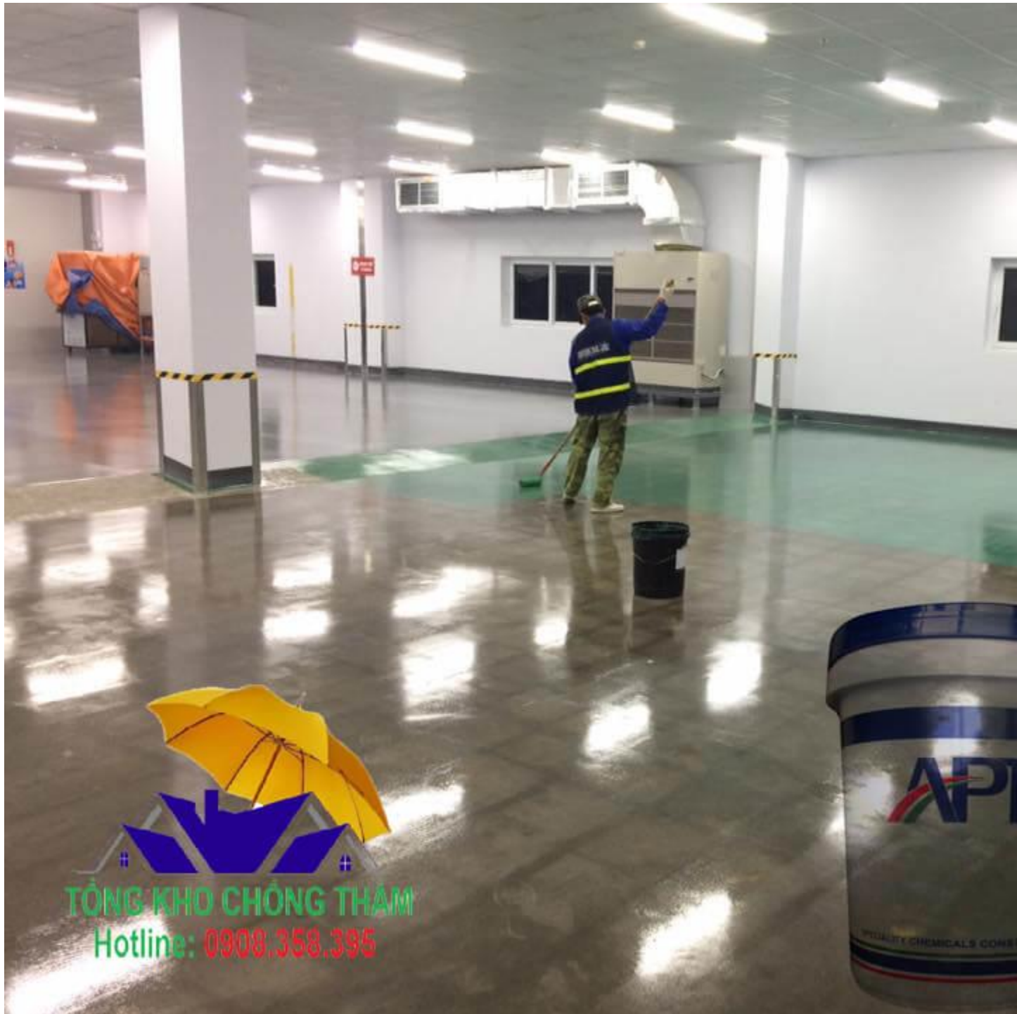
Cách thi công sơn Epoxy kháng hóa chất hãng APT
