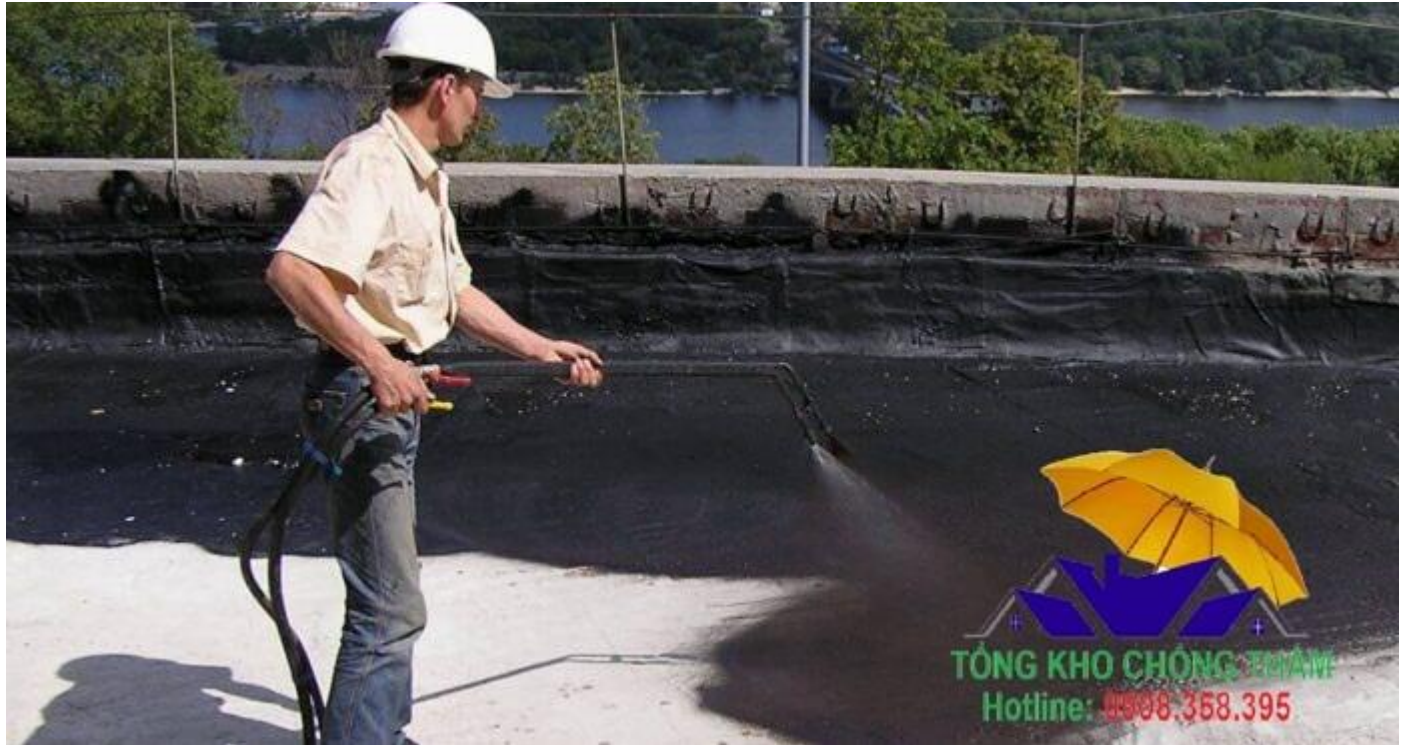
Chống thấm góc Bitum
