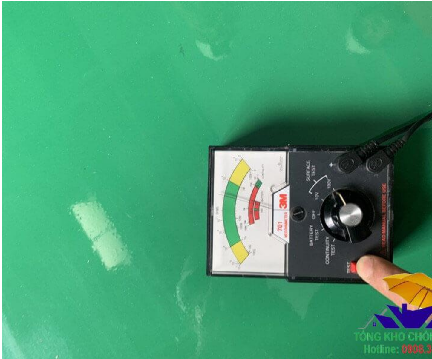
Điều kiện thi công
