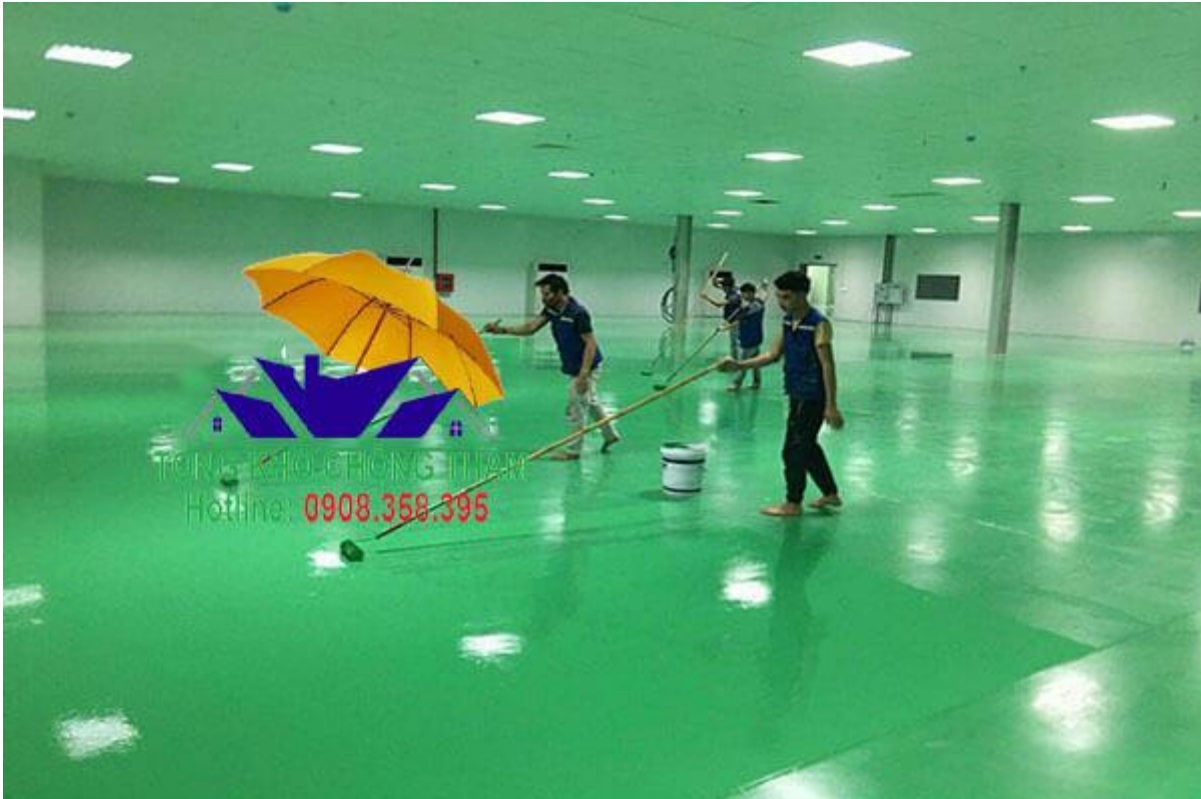
Sơn Epoxy gốc nước được sử dụng ở đây
