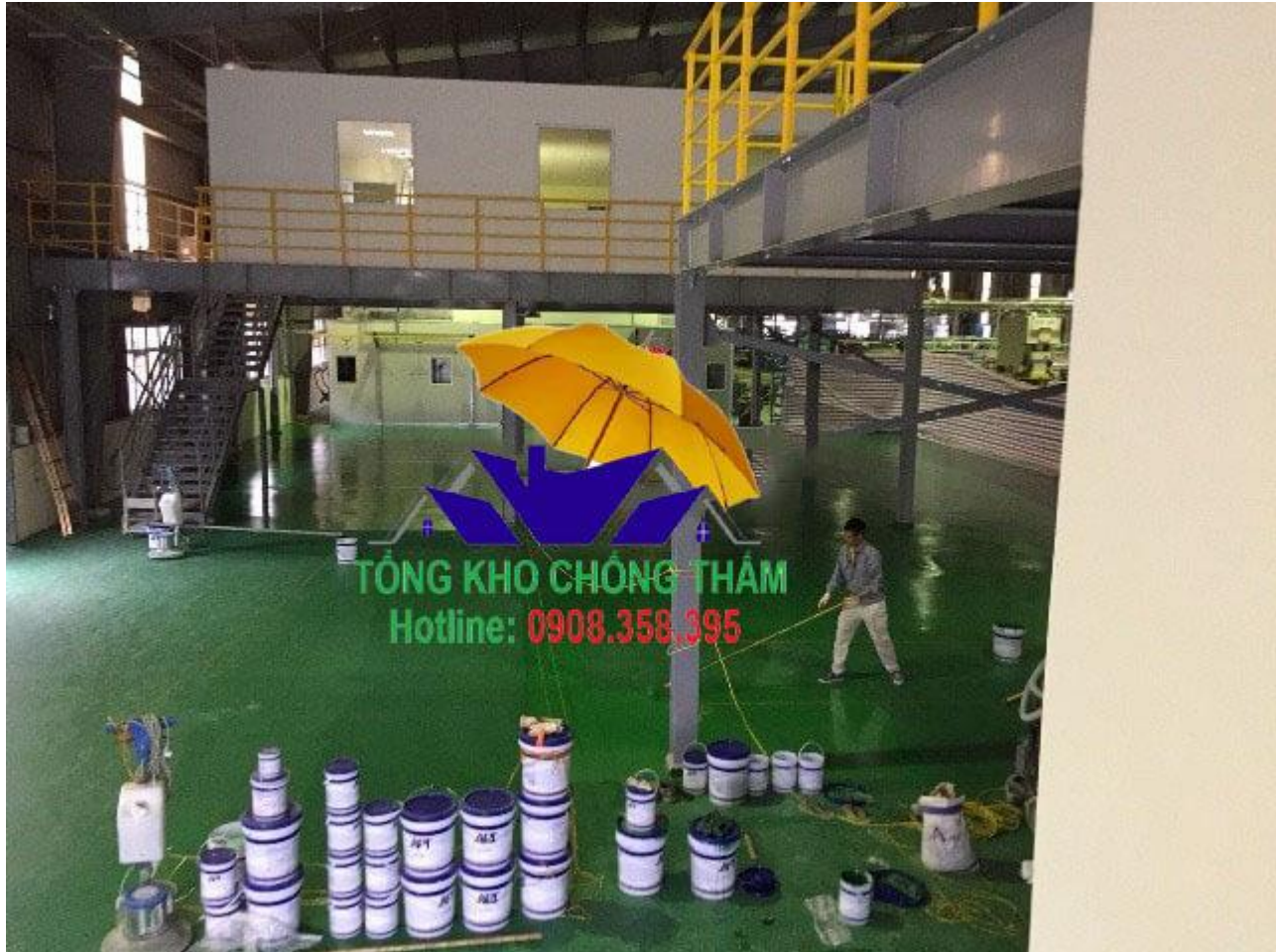
Thi công sơn phủ Epoxy Keraseal WB20 hãng APT
