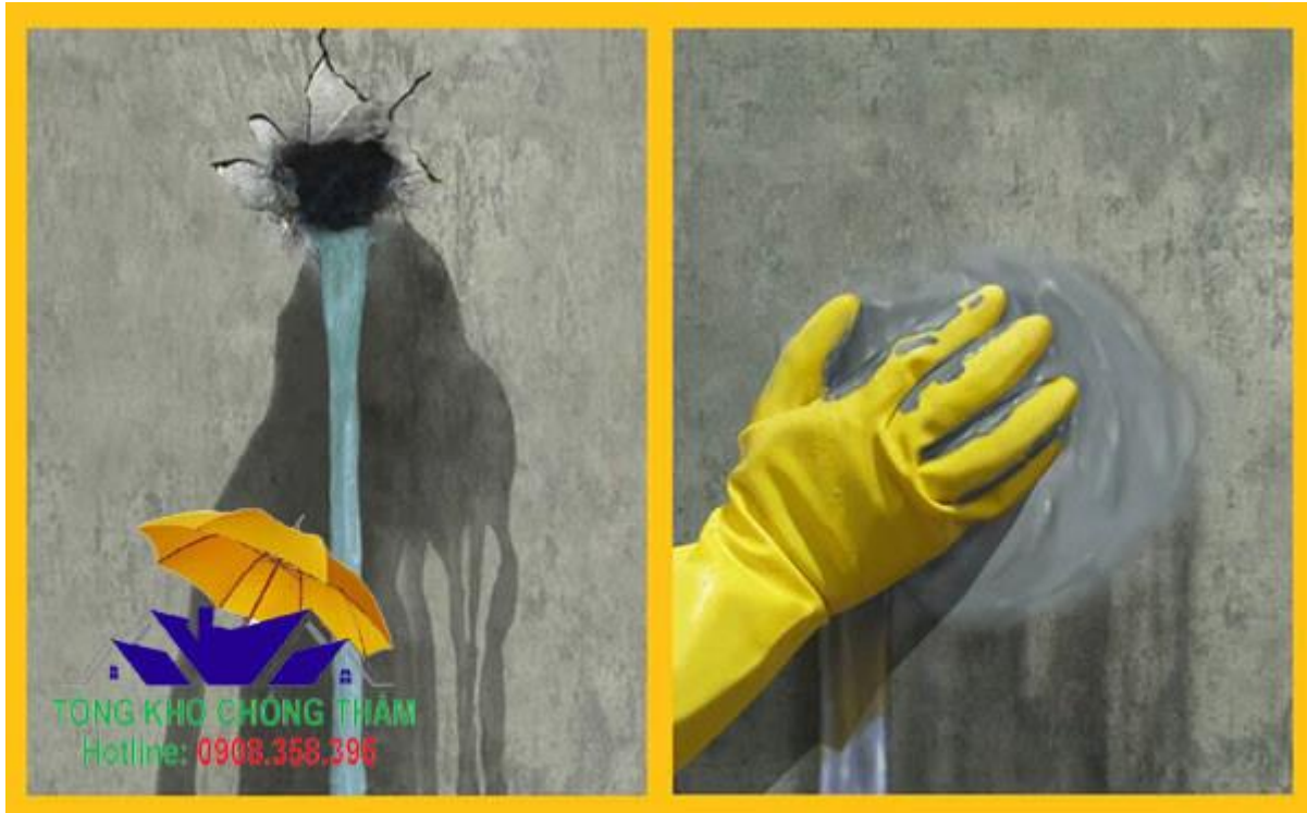
Hình ảnh minh họa khi dùng vữa trộn sẵn đông cứng nhanh
