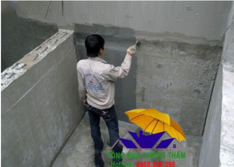
Cách thi công hợp chất chống thấm 2 thành phần
