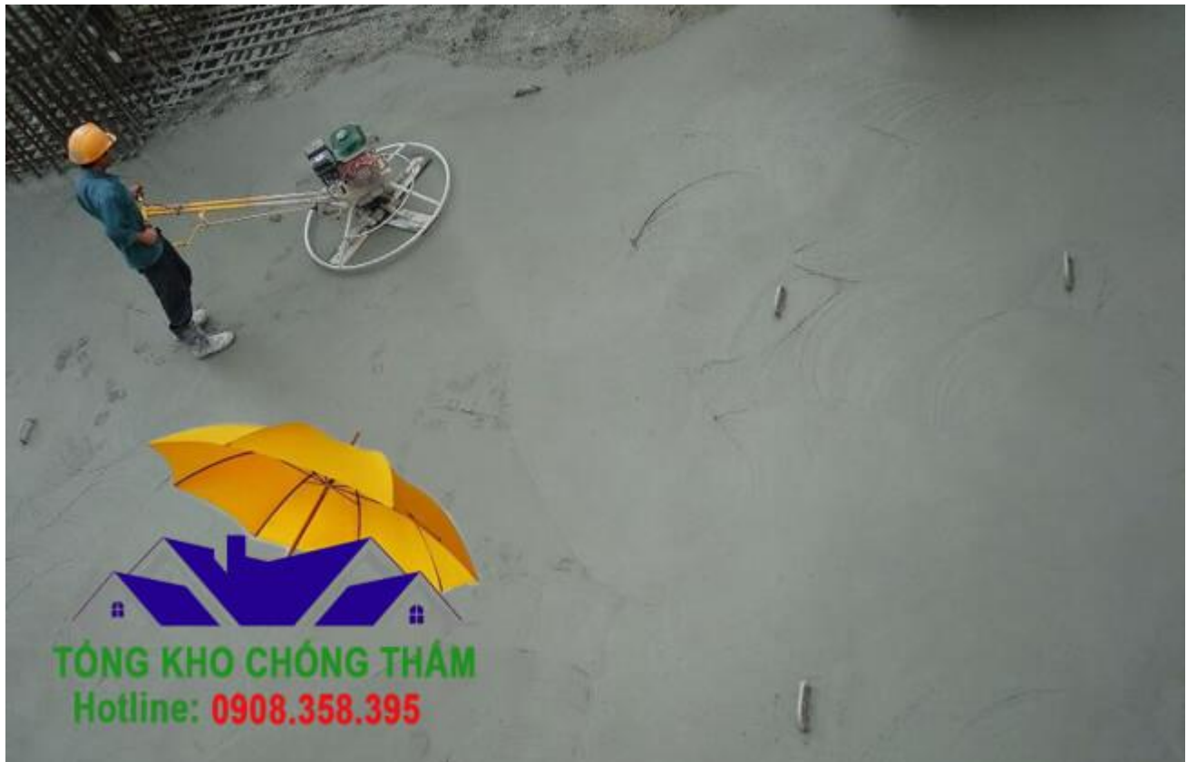
Thi công xoa nền tăng cường sàn bê tông bằng Victatop
