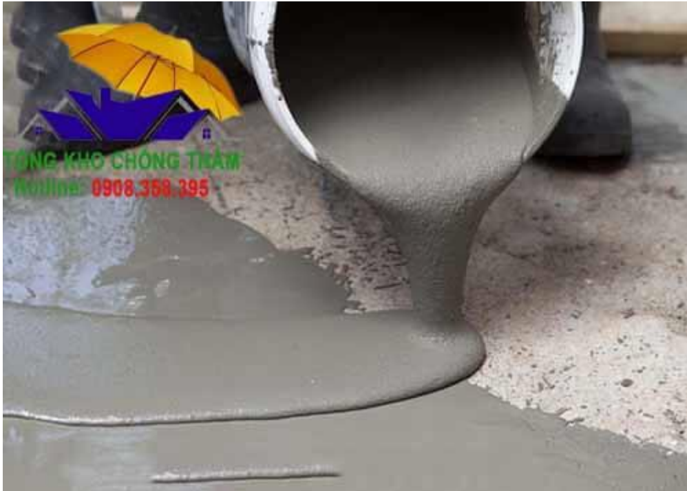
Hướng dẫn cách thi công vữa rót Epoxy Grout CS100
