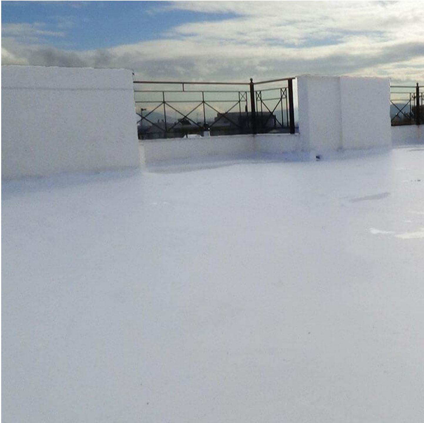
Hiệu quả khi thi công
