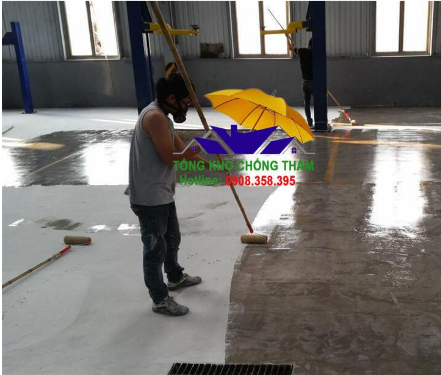
Hướng dẫn cách thi công sơn lót gốc PU
