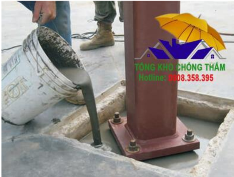
Thi công vữa rót không co ngót Victa Grout EHS
