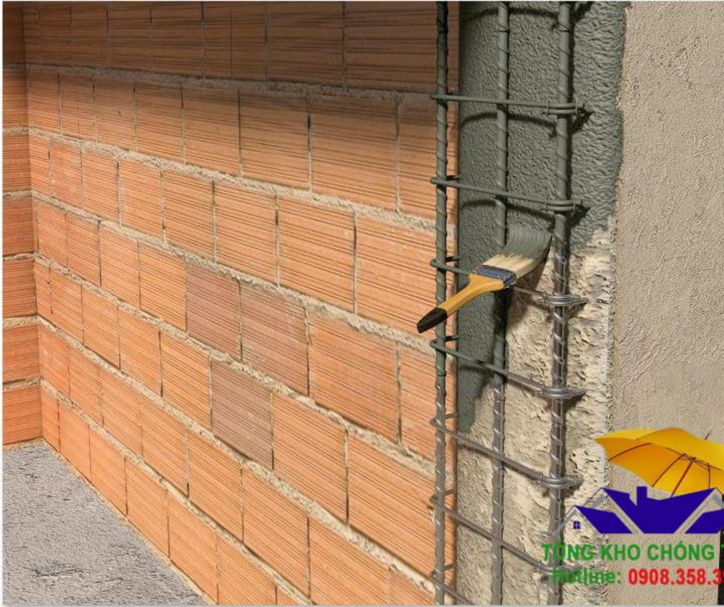
Thi công vữa sửa chữa bê tông Victa mortar RP
