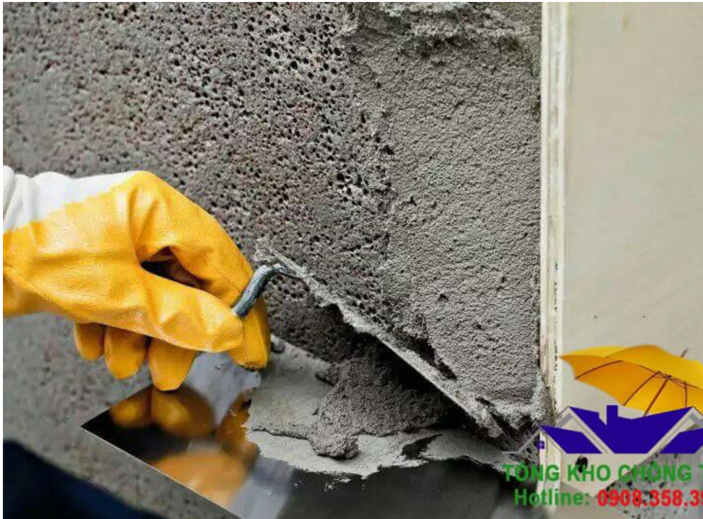
Cách thi công vữa chống thấm ngược Compact RP 500
