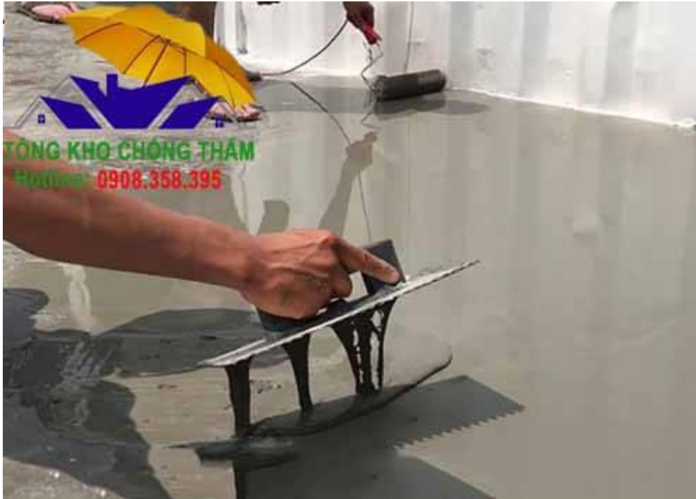
Cách thi công vữa tự san phẳng AC Leveling
