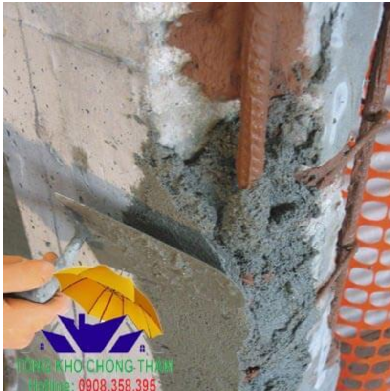
Một số lưu ý trong quá trình thi công
