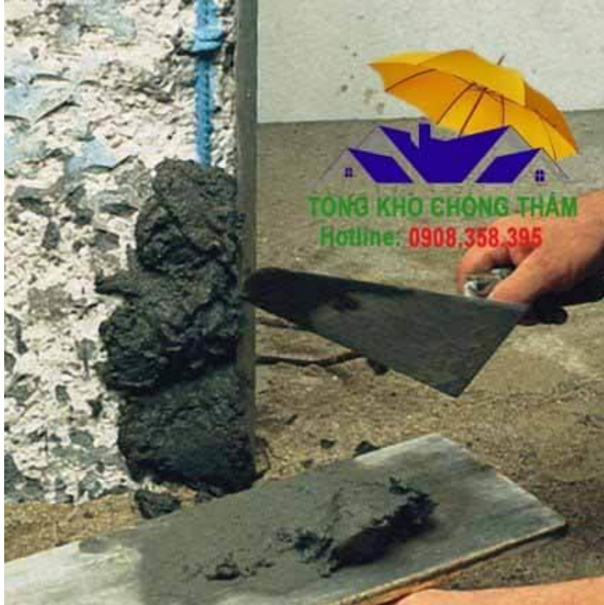
Cách thi công vữa sửa chữa Mortar
