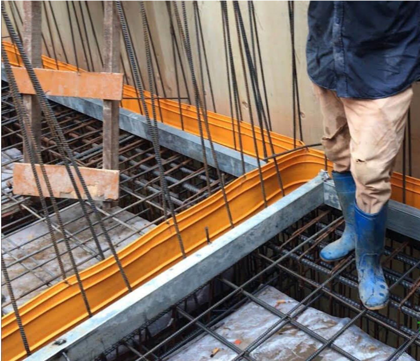
Cách thi công băng cản nước Waterstop 0320
