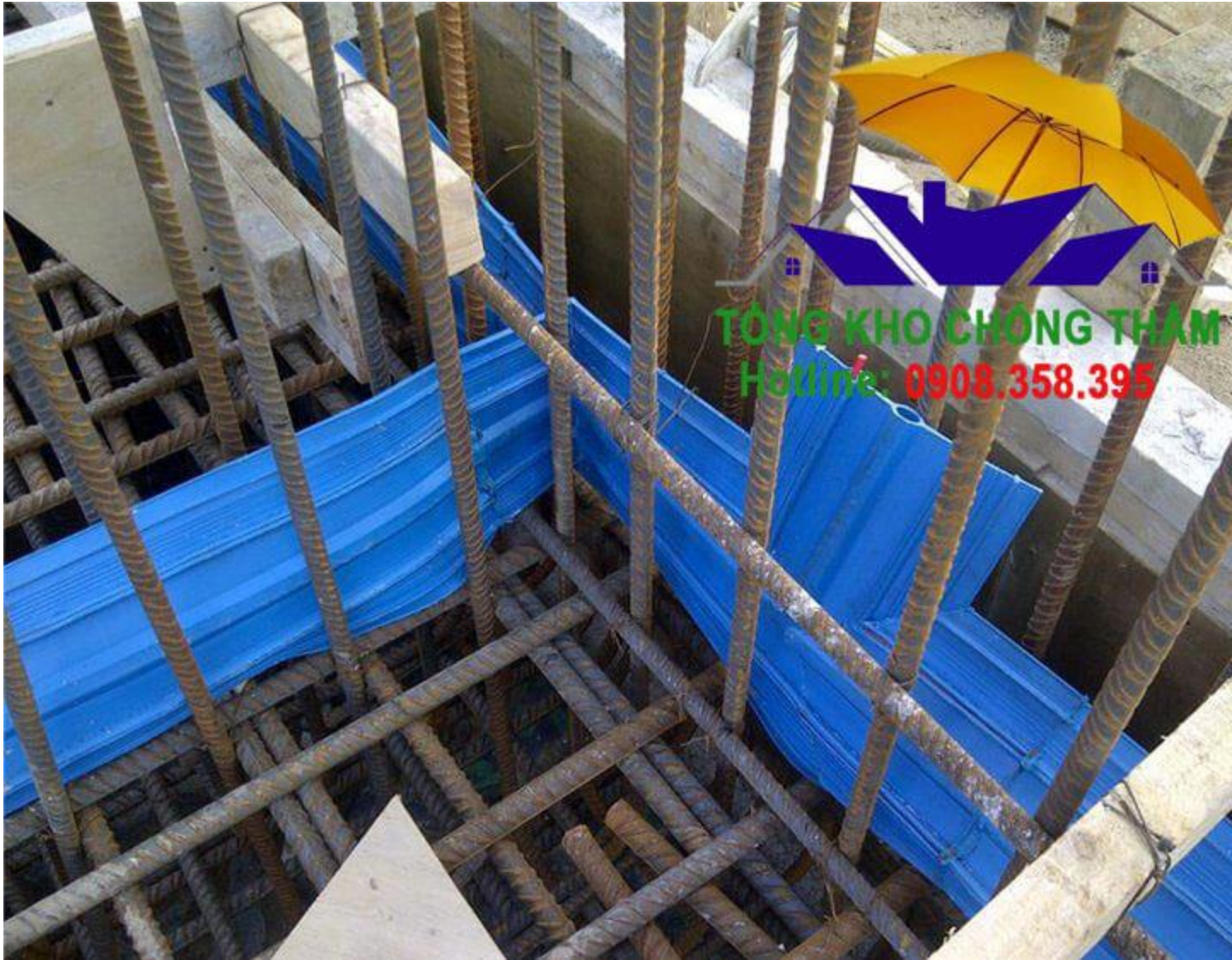
Cách thi công băng cản nước Waterstop PVC 0250
