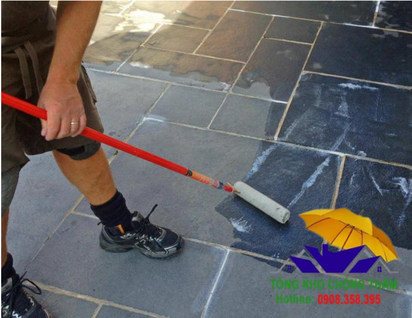
Cách thi công chất chống thấm đá AWS 3000
