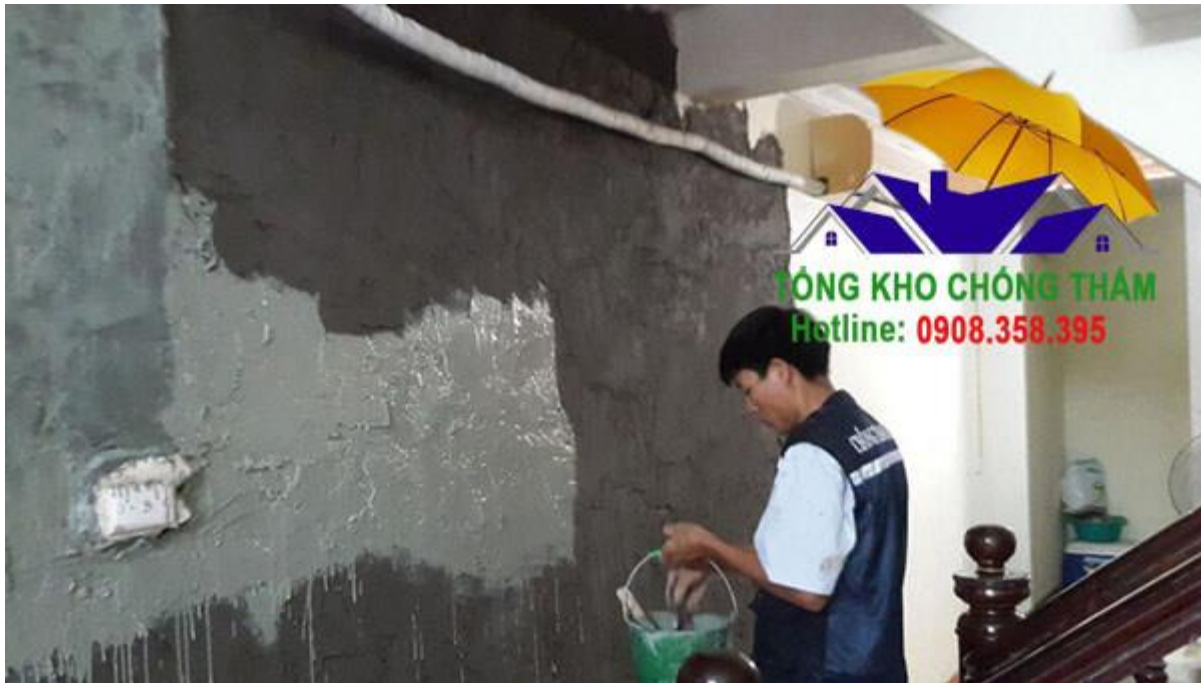
Cách thi công chống thấm ngược bằng Compact MT 100
