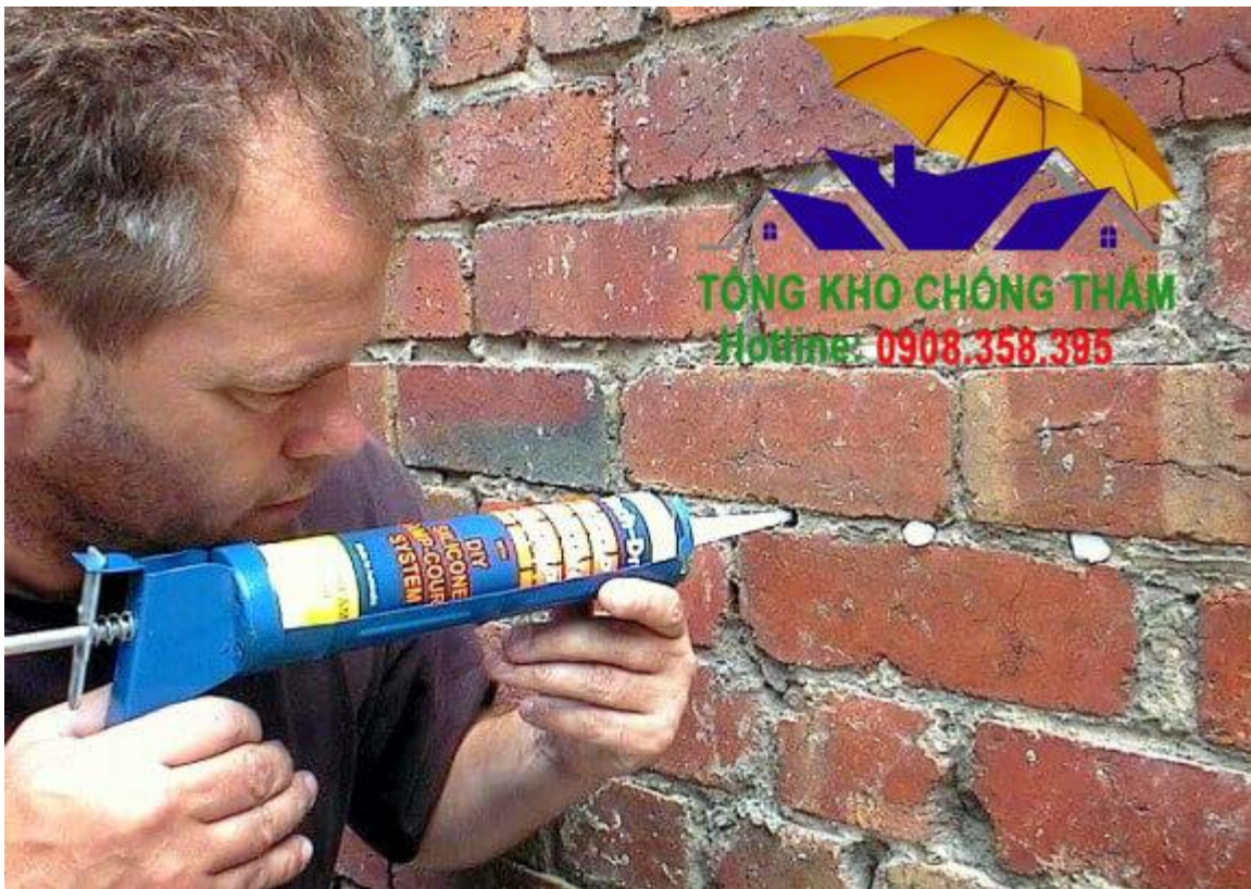
Lưu ý khi thi công
