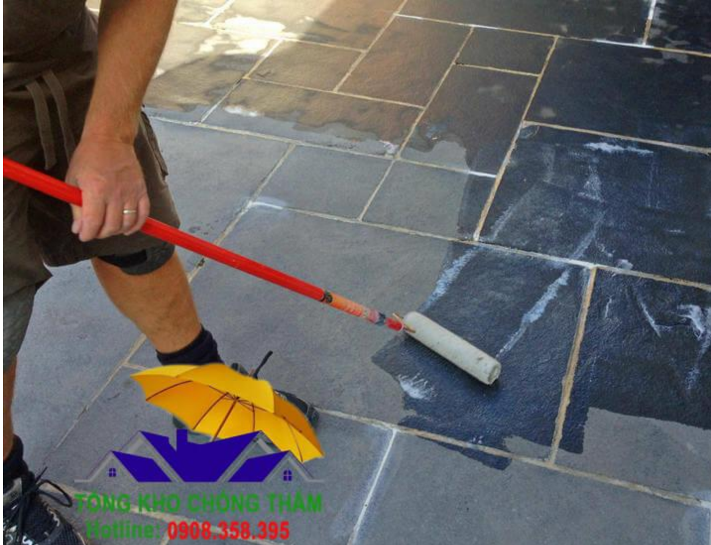
Hướng dẫn cách thi công Roxseal Stone
